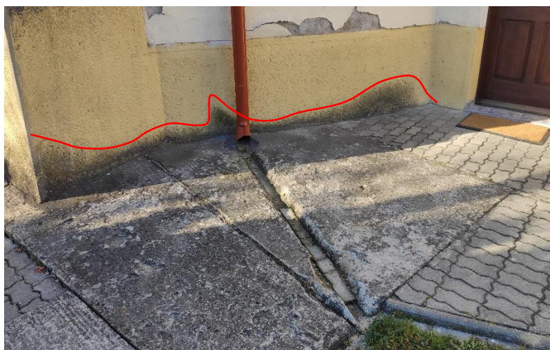
Obr. č.1 – Betónová plocha s povrchovým odvodňovacím žľabom
