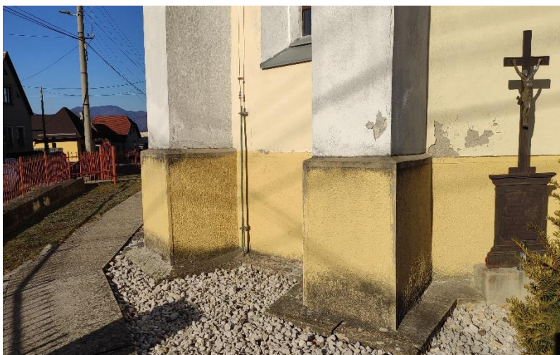
Obr. č.6 – Čierne povlaky v mieste intenzívneho zaťaženia vlhkosťou - presbytérium
